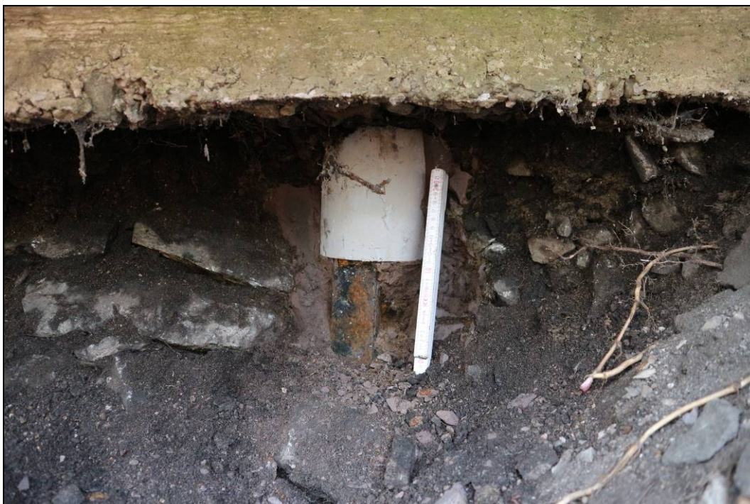
Obr. č. 4 - detail mikropiloty - nechráněná část zasažena povrchovou korozí
