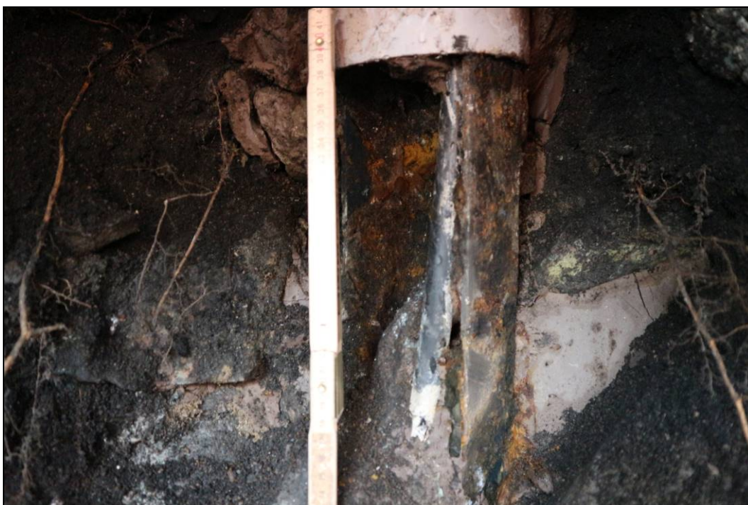
Obr. č. 7 - detail mikropiloty pod dříkem zdi, vlevo vedle patky stožáru TV č. 36
