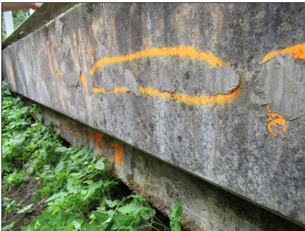
Obr. č. 3 - pohled na římsu zdi - místa odtrhových zkoušek a měření hloubky karbonatace
